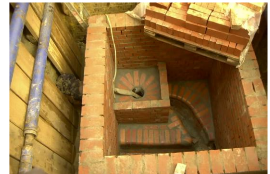
Absturzbauwerk in der Kanalisation
